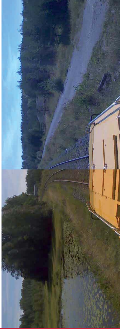
Bild 114 KM 18+933-19+245 Väg föreslås slopas alt. flyttas till 8 m från spårmit. Avgränsas med stängsel.
