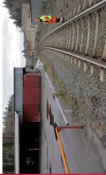
Bild 121 KM 19+672-927 Ytan avgränsas med stängsel/kantsten 5 m från spårmit. Stolpar placeras på höger sida i längdmätningens riktning.
