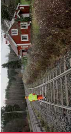
Bild 077 KM 15+080 Stolpar måste placeras på -255 höger sida i längdmätningens riktning för att ta hänsyn till vägen. Hänsyn tas till villa.
