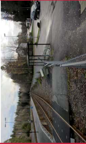
Bild 129 KM 19+853 Yta måste frigöras till 8 m från spårmittpå -900 höger sida om spåret i längdmtningens riktning för stolpplacering och elsäkerhetsavstånd.
