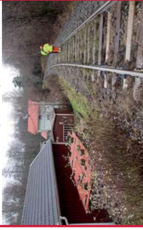
Bild 077 KM 15+080 Stolpar måste placeras på -255 höger sida i längdmätningens riktning för att ta hänsyn till vägen. Hänsyn tas till villa.
