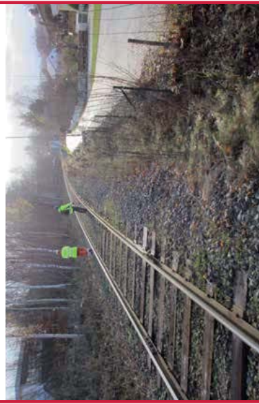
Bild 015 KM 8+517 Armatur byts till klass 2 KM 8+846 Armatur byts till klass 2
