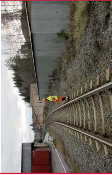
Bild 124 KM 19+677-714 Byggnad rivs. Stolpar placeras på höger sida i längdmätningens riktning.
